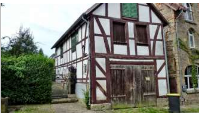
-16- Straßenansicht von Nordosten
