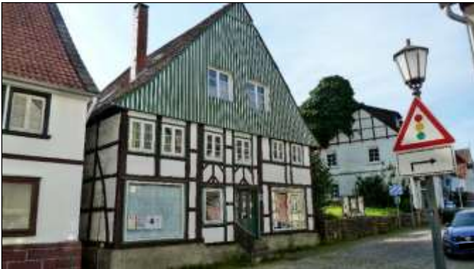
-1- Straßenansicht von Nordwesten
