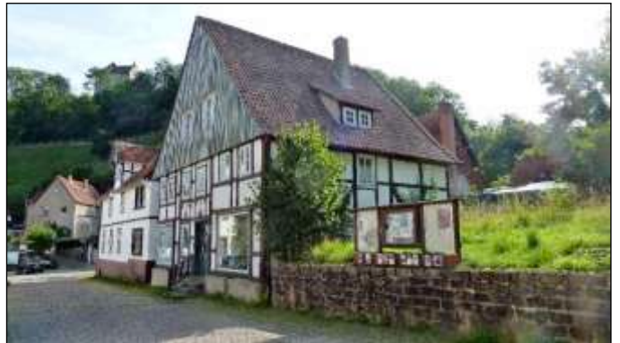
-2- Straßenansicht von Südwesten
