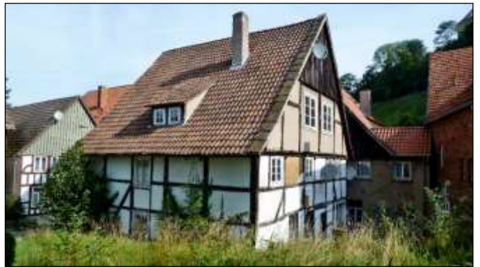
-4- Ansicht von Südost
