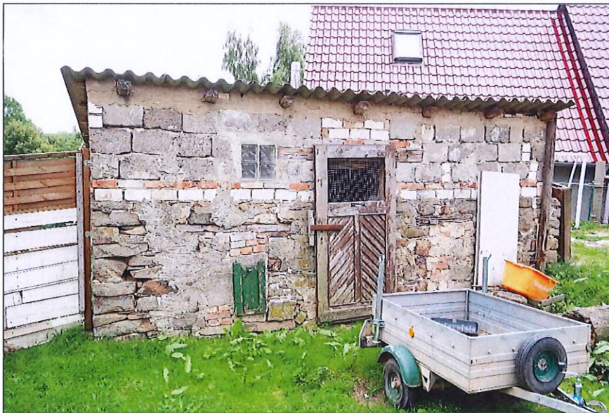
ehemaliger Hühnerstall - Nordwestansicht
