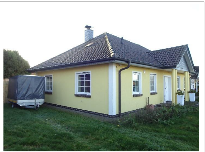
Ansicht vom Nordost
